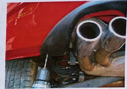
Abb. 4 Bohrung für äußere Befestigungspunkte
