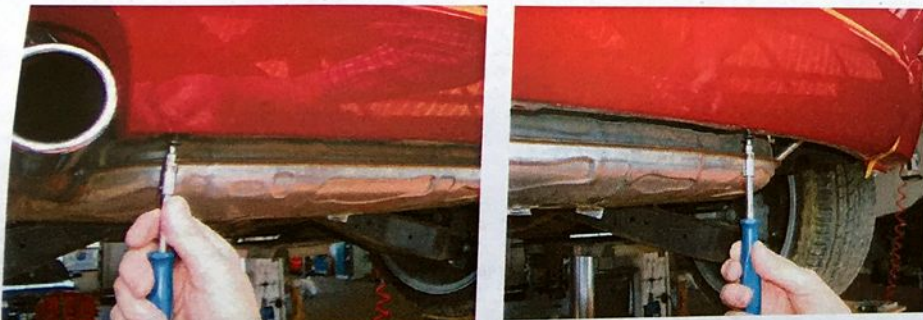
Abb. 1+2 Demontage der Originalbefestigung
